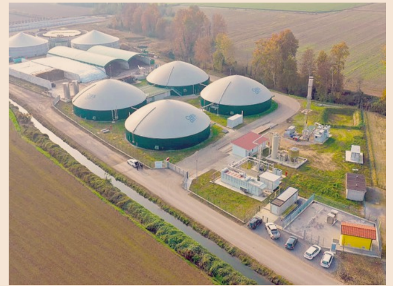
Biometano. Un impianto di produzione
